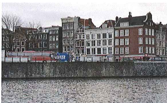
De "Muur" van het Oosterdok
