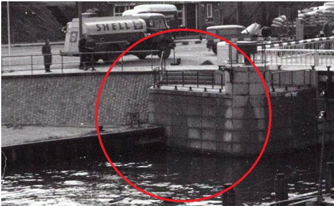
Brug 314 kort na de oplevering (foto oktober 1960). De lage kade is een wachtplaats voor de sluis. Het talud is bekleed met zeskantige keien. Het landhoofd van de burg is voorzien van natuurstenen platen. Talud, landhoofd en brug vormen één architectonische compositie. Bij het verleggen van de kademuur moet het vrije zicht op het landhoofd intact blijven en moet een logische aansluiting worden gevonden tussen brug en kade.
