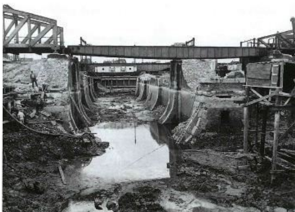
Sloop in 1959 van de in 1843 gebouwde Westerdokssluis met twee draaibruggen van de Nederlandse Spoorwegen.
