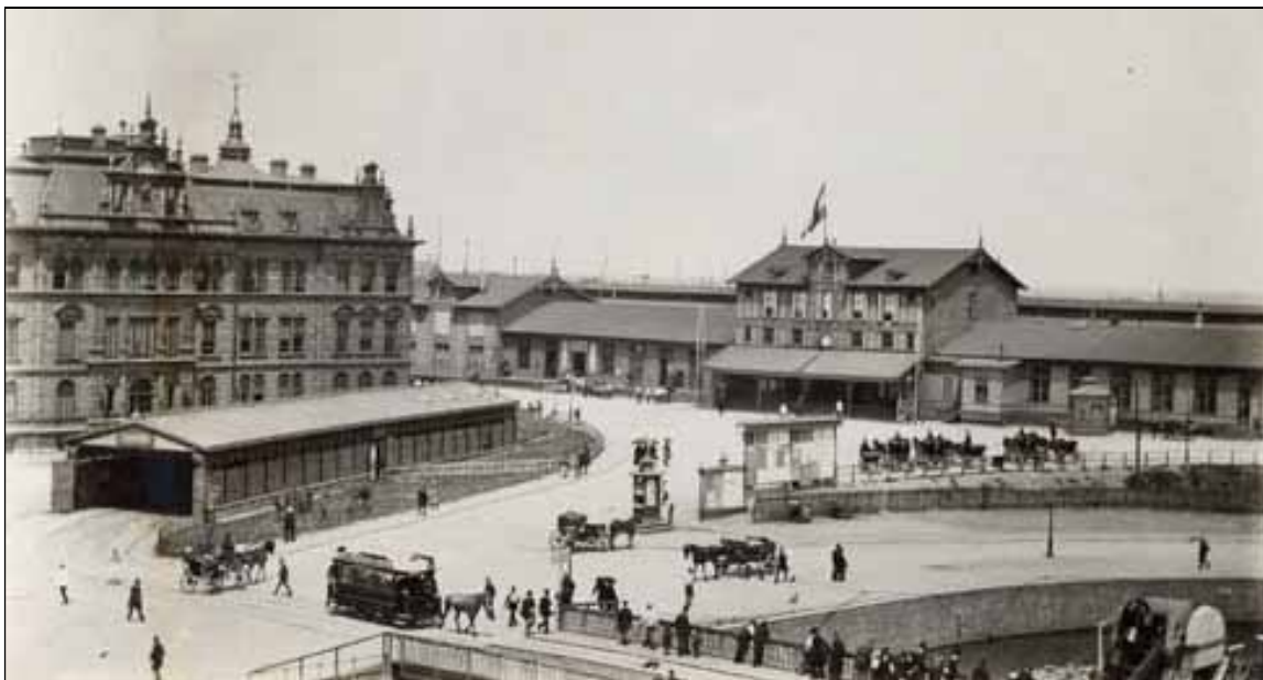
7 Het in 1884 voltooide administratiegebouw van de Hollandsche IJzeren Spoorweg Maatschappij, het Tijdelijke Station en de paardentramremise, ca. 1889, vgl. afb. 6 (SAA)
