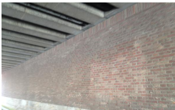
Nieuwe kademuren in het plangebied
