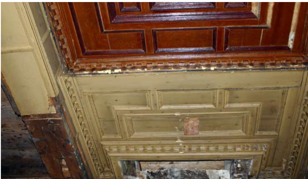
8 Restant van een zestiende-eeuws cassetteplafond (circa 1557-1560) in Warmoesstraat 145. Voor dit plafond kwam de bouwhistorische waardenkaart te laat: het werd in 2007 afgebroken omdat het bestaan ervan niet tijdig bekend was.
