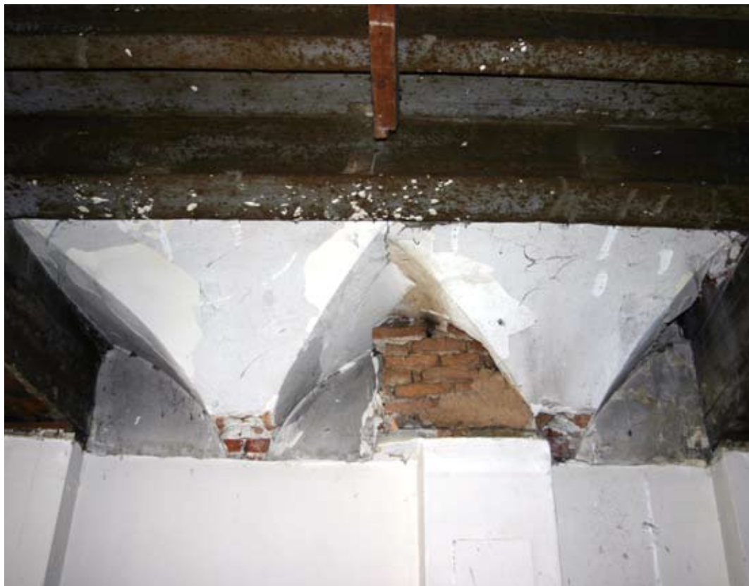
10 Voorbeeld van een kwetsbaar bouwhistorisch relict: een zestiende-eeuws haardgewelf ter ondersteuning van de stookplaats op de verdieping erboven (Warmoesstraat 145).
