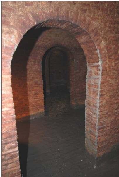
13 Een doorkijk door de compartimenten van de waterkelder onder weeshuis De Laurier, tijdens bouwwerkzaamheden in 2010 gedocumenteerd (LAU3)
