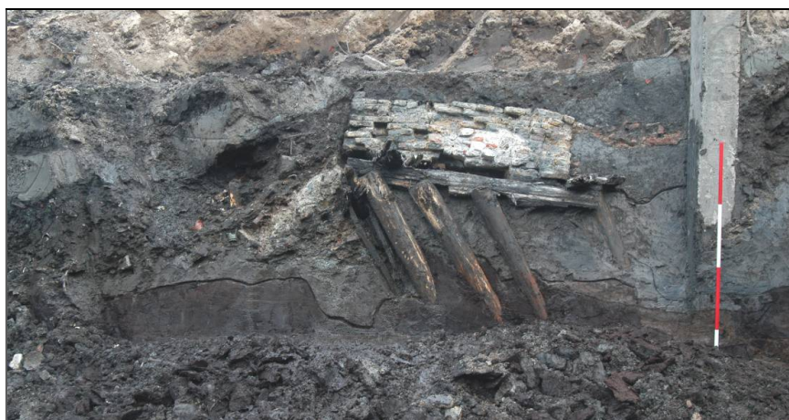
12 Noordprofiel van opgraving MAR 2; goed zichtbaar is hoe de schildmuur inclusief onderliggende fundering door de druk van het wallichaam was verzakt in westelijke (links) richting. Bron: BMA AAR 30
