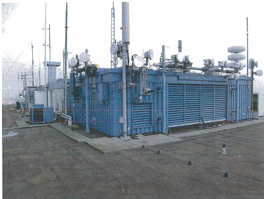
Dakopbouw westgevel en kopgevel zuid
