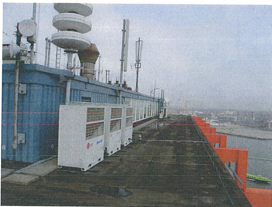
Dakopbouw oostgevel gezien naar het noorden
