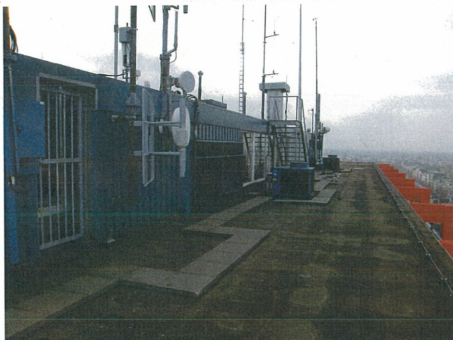
Dakopbouw westgevel gezien naar het zuiden
