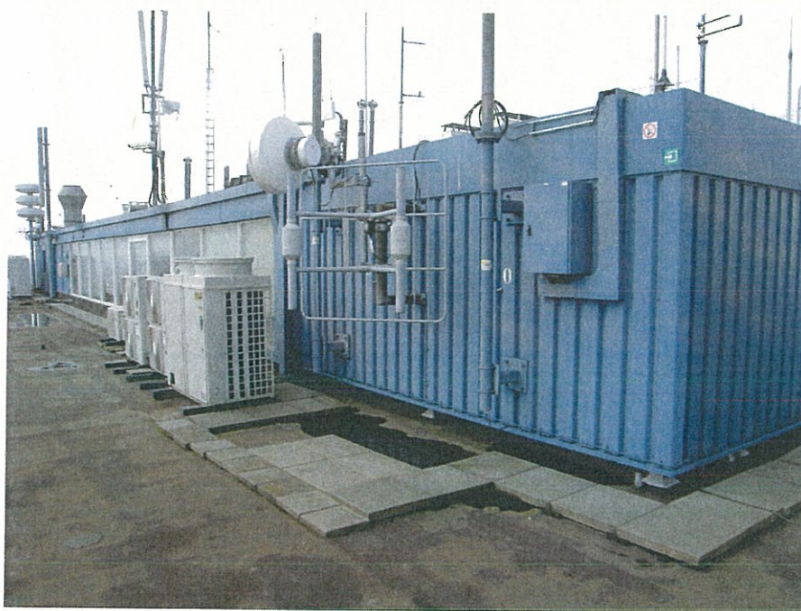
Dakopbouw oostgevel gezien naar het zuiden
