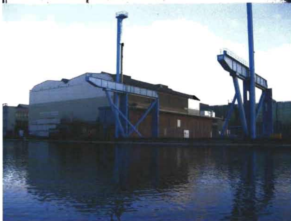
De blauwe hijsconstructie uit 1978 met links daarnaast de Langhout-hallen uit de dertiger jaren met de in 1993 aangebrachte gevelprofiel.
