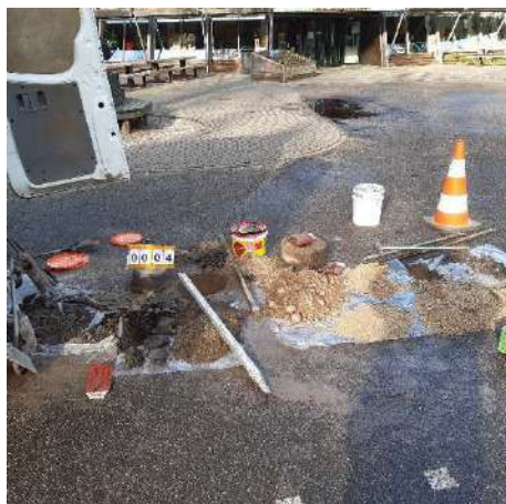
Fotonummer: 3 Omschrijving: Boring 03dB04
