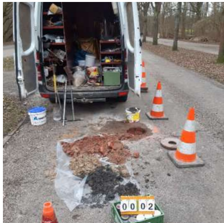
Fotonummer: 1 Omschrijving: Boring 03dB02
