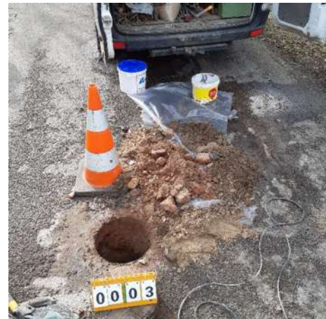
Fotonummer: 2 Omschrijving: Boring 03dB03
