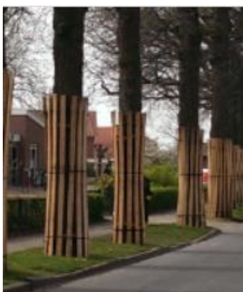
Afbeelding 10: Voorbeeld stambescherming
