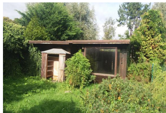
Foto 10: Geïntervieweerde carport vanuit zuidoostelijke richting gezien. (geen asbest waargenomen)
