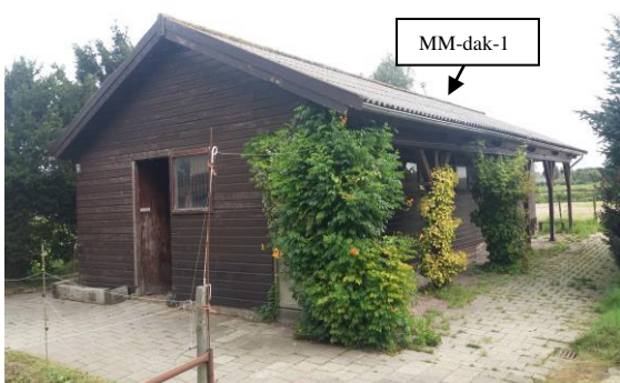
Foto 5: Geïntervieweerde schuur 1 met asbesthoudende golfplaat als dakbedekking vanuit zuidwestelijke richting gezien.
