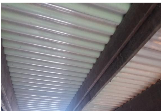
Foto 11: Dakbedekking van carport van binnen gezien. (p.v.c. en polyester golfplaat)
