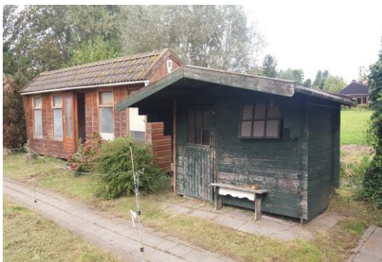
Foto 7: Geïntervieweerde schuren 2 en 3 vanuit zuidoostelijke richting gezien. (geen asbest waargenomen )
