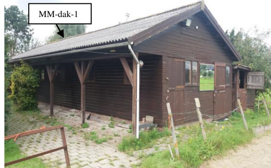
Foto 6: Geïntervieweerde schuur 1 met asbesthoudende golfplaat als dakbedekking vanuit zuidoostelijke richting gezien.
