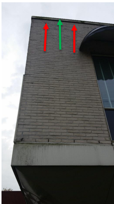
Foto 5 locaties van de openstootvoegen (rood) en boeideel (groen)
