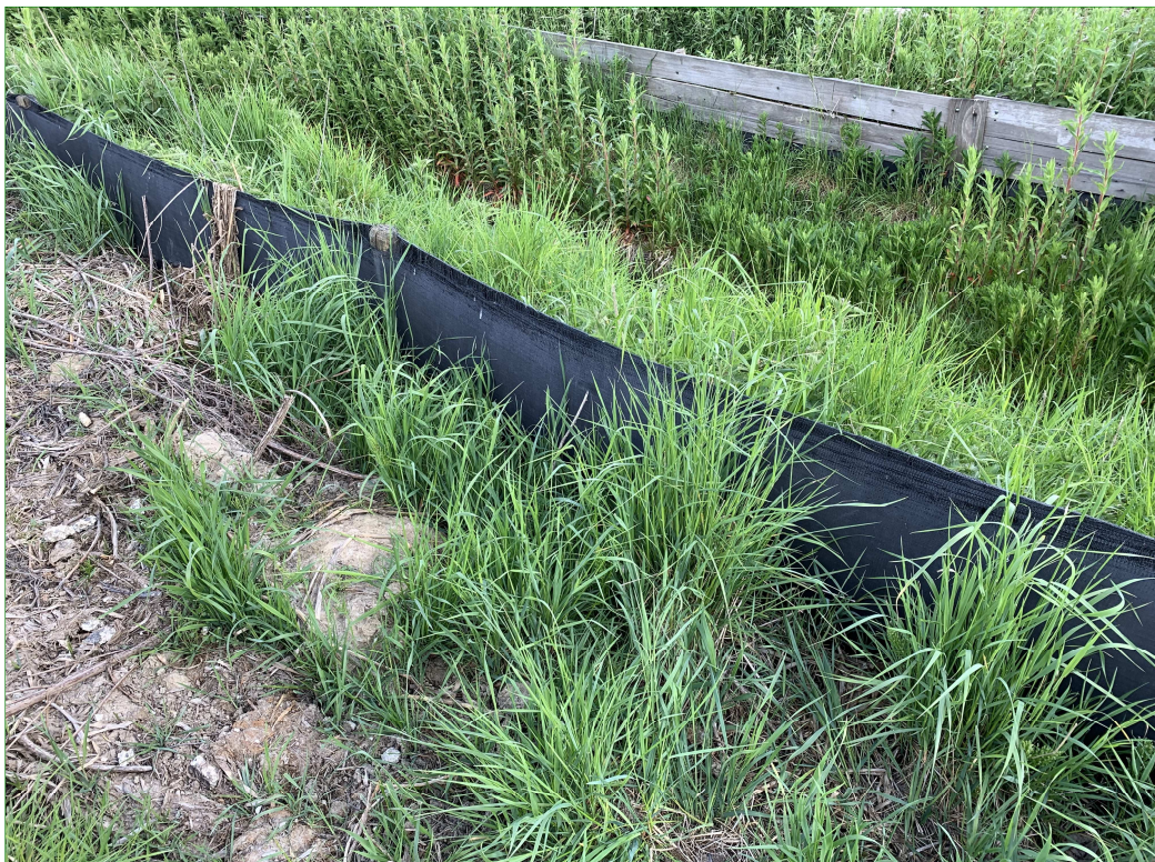
Worteldoek/amfibieënscherm en houten beschoeiing.
