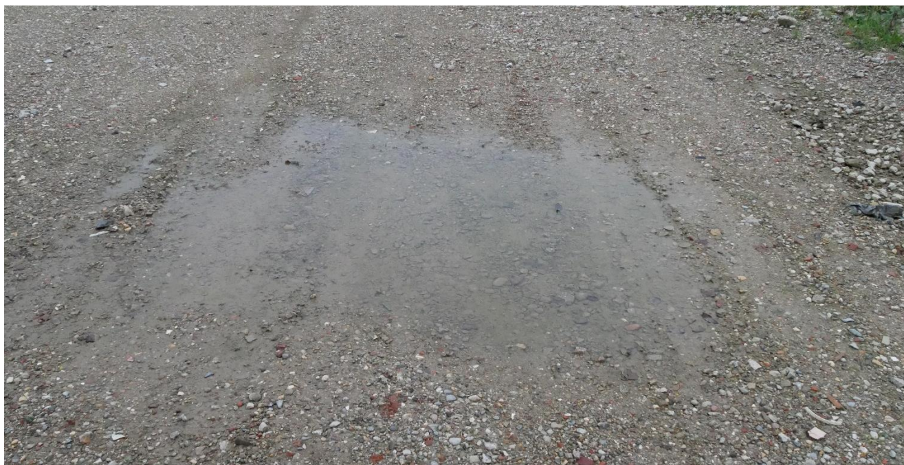
Afbeelding 6: zeer ondiep stagnerend water op granulaat
