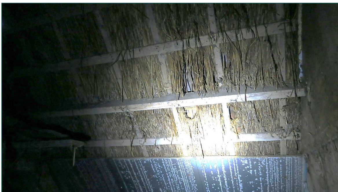
Figuur 4 Impressie van de binnenzijde van het dak in de te slopen bijgebouw.
