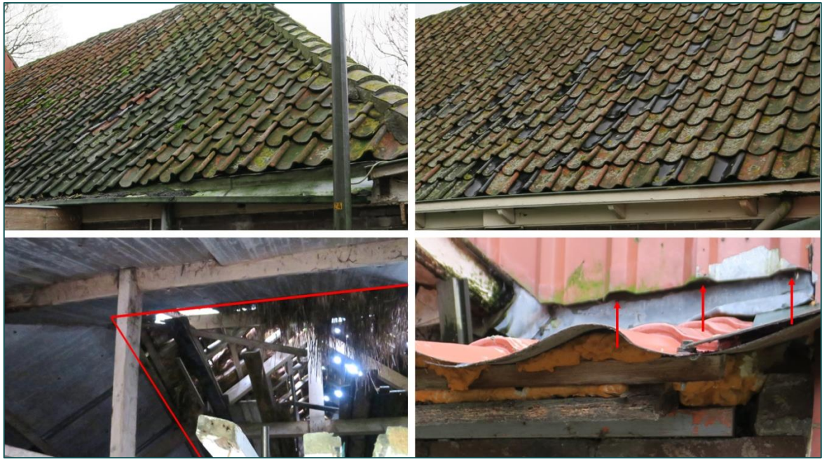
Figuur 3.2 Impressie van de potentiële invliegopeningen voor vleermuizen in het te slopen bijgebouw. De rode lijnen (linksonder) geven aan tot waar de isolatieplaten onder het dak loopt. De rode pijlen (rechtsonder) geven de openingen tussen de damwand en de gevel weer.
