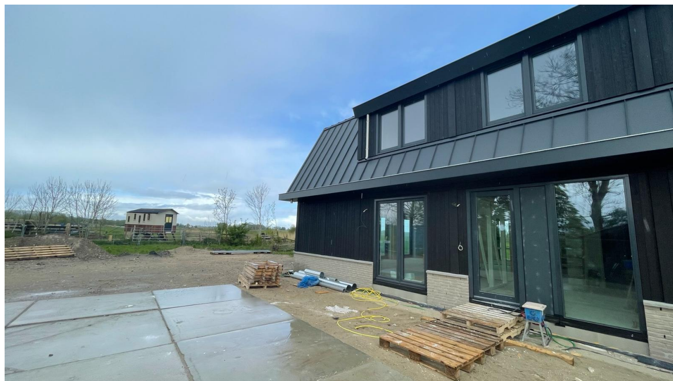
woonhuis (in aanbouw) met achtererf
