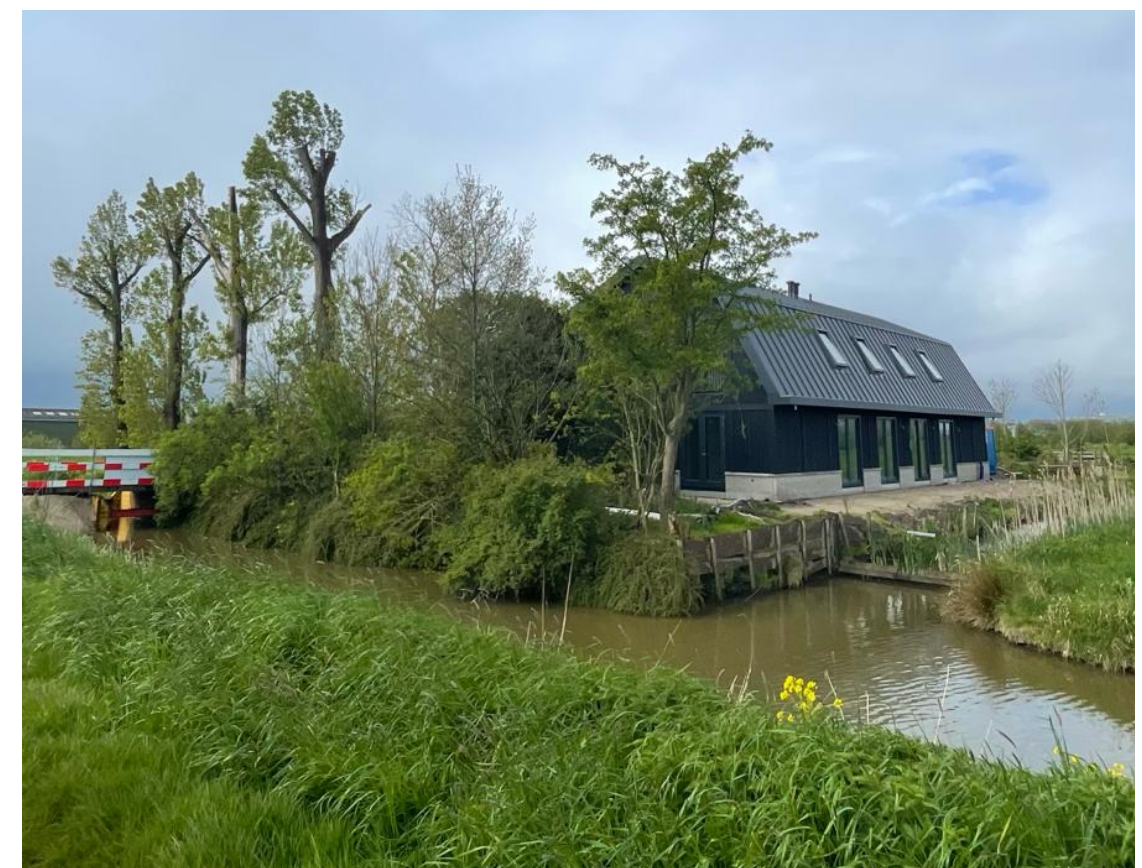
aanzicht erf en woonhuis vanaf straatzijde
