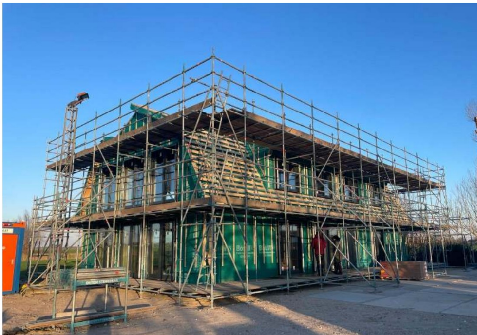
Werkzaamheden woonhuis op BP 1 (januari '24)
