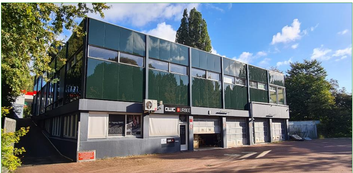
Zuidkant van het plangebied: Het souterrain van het bedrijfspand is goed zichtbaar.
