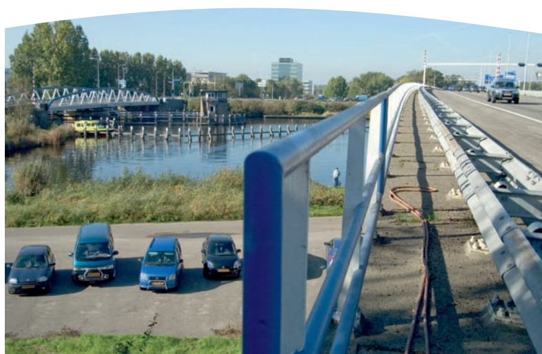
Brug over de Ringvaart.
