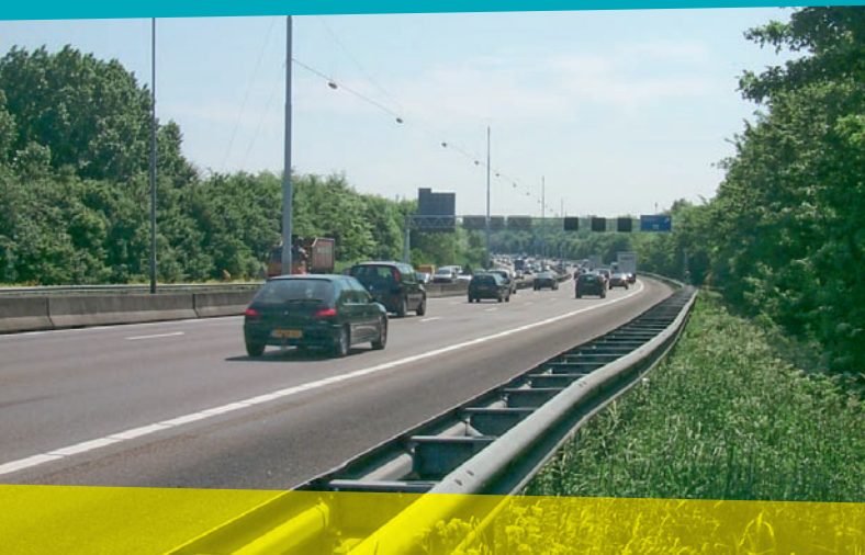
Het Amsterdamse bos: een duidelijk herkenbaar deel van de A9.
