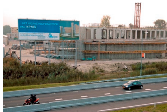
Bouw van het nieuwe hoofdkantoor KPMG langs de A9 bij Amstelveen (oost).
