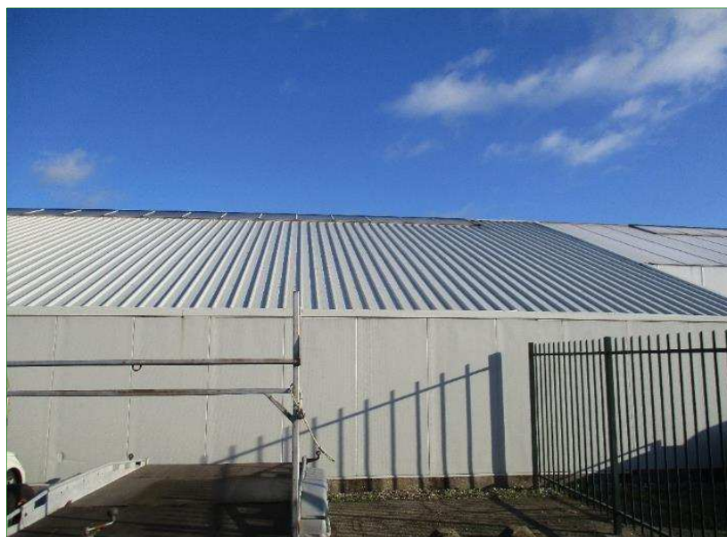
Loods bestaande uit metalen sandwich panelen.
