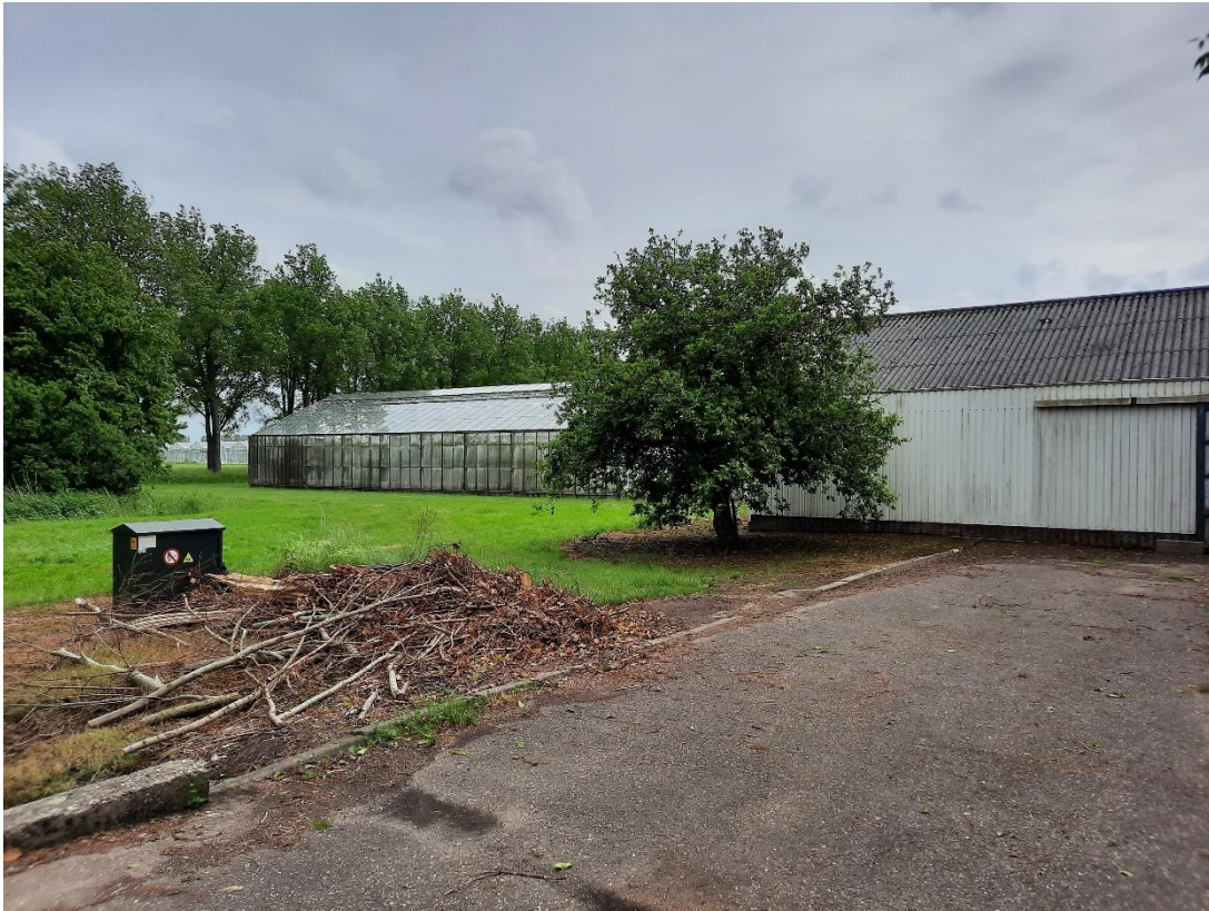
Foto 9. Glastuinbouw, toerit, golfplaten
