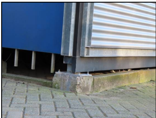
Afbeelding 5: Opening tot fietsenstalling noordelijk utiliteitsgebouw
