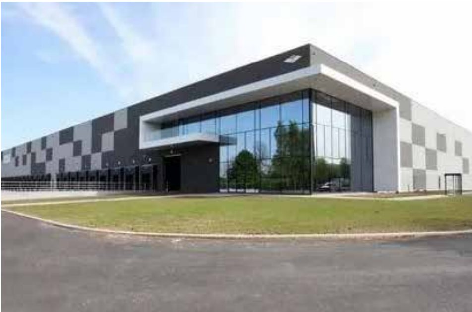
hoek met grootschalige geleding
