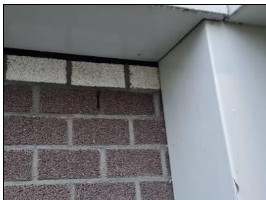
Afbeelding 4: Invliegopening voor gebouwbewonende vleermuizen
