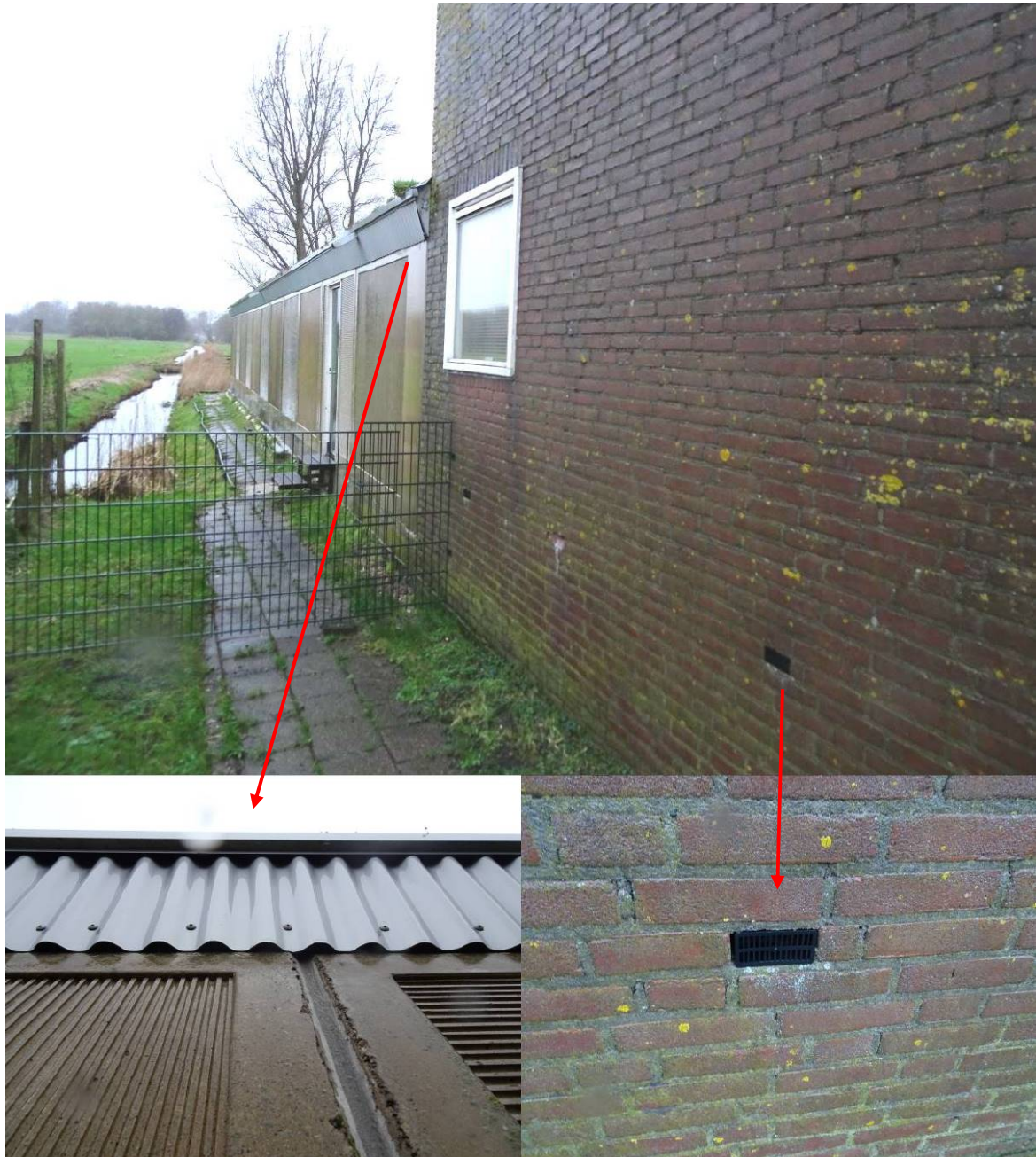
Figuur 4. Bevestigingsmateriaal achter platen en roosters voor ontluuchtingsplaatsen aan de Kostverlorenweg 12 te Amstelveen.
