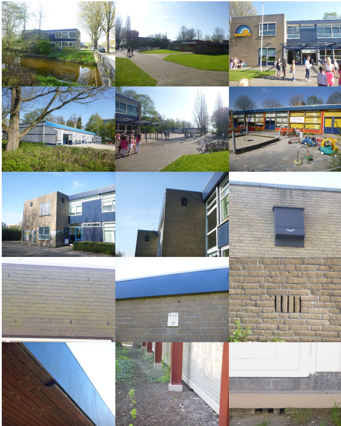
Figuur 2-2. Huidige situatie bebouwing plangebied. Van boven naar onder en van links naar rechts: basisscholen, schoolpleinen, vleermuiskasten met restanten van uitwerpselen, open stootvoegen en ventilatieopeningen spouwmuren, gaten onder dakafwerking en openingen onder aan de fundering en de spouwmuur.
