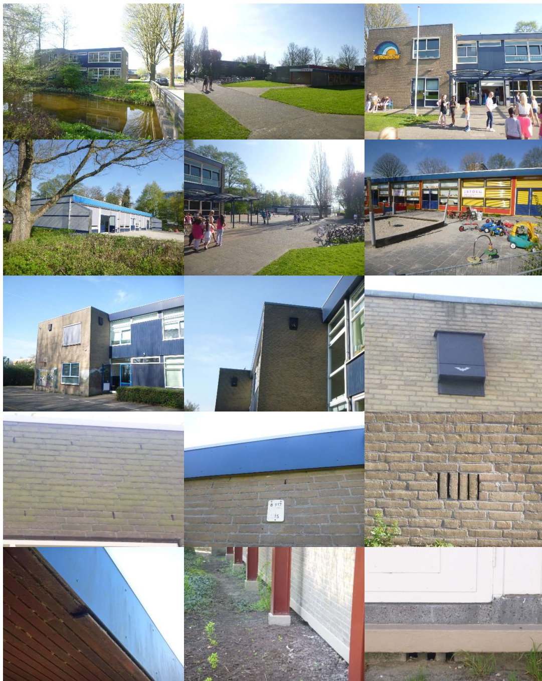
Figuur 2-2. Huidige situatie bebouwing plangebied. Van boven naar onder en van links naar rechts: basisscholen, schoolpleinen, vleermuiskasten met restanten van uitwerpselen, open stootvoegen en ventilatieopeningen spouwmuren, gaten onder dakafwerking en openingen onder aan de fundering en de spouwmuur.
