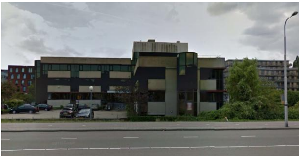
Afbeelding 2. Voormalig kantoorpand Groenelaan 3. Aanzicht vanaf de Groenelaan
