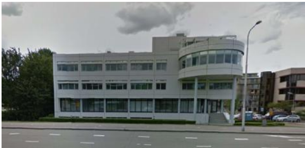
Afbeelding 4. Voormalig kantoorpand Groenelaan 5. Aanzicht vanaf de Groenelaan
