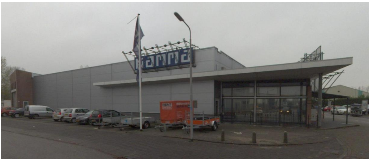
Figuur 6: aanzicht zuidgevel huidige Gamma aan de Grutterij 1
