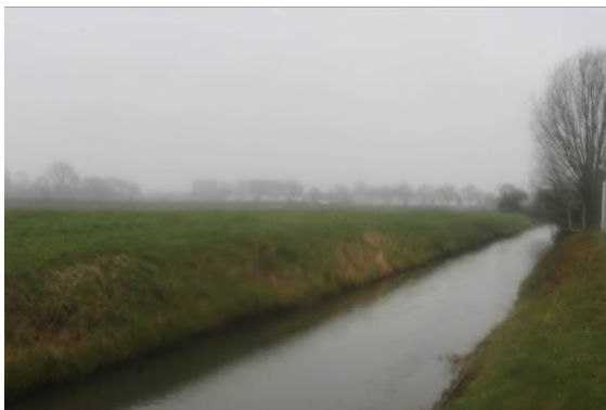
figuur 3.4. brede watergang - westzijde van de spoordijk
