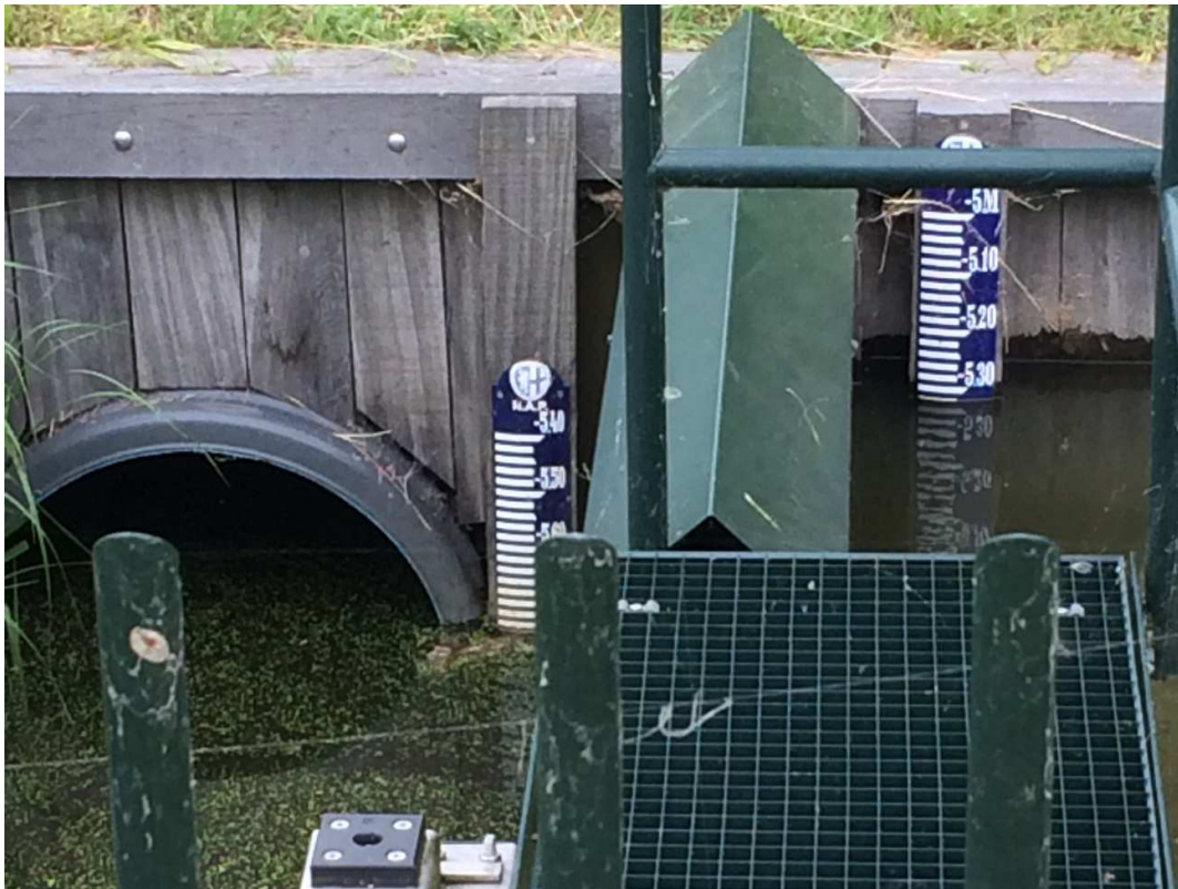
Figuur 7: Stuw in de Amstelveense Toch (westelijk gelegen watergang). Hieruit blijkt het verschil tussen het noordelijke peilvak (NAP -5,37 m) en zuid (NAP -5,8 m) en de duiker welke de watergang ten zuiden van de J.C. van Hattumweg en ten westen van het plangebied met het zuidelijke peilvak verbind.
