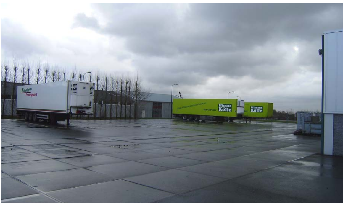
Foto 4: Gezicht vanuit zuidzijde op noordzijde RE03 en RE01.
