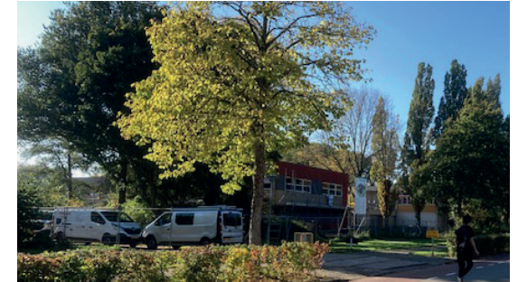
Schoolgebouw met gymzaal in aanbouw
