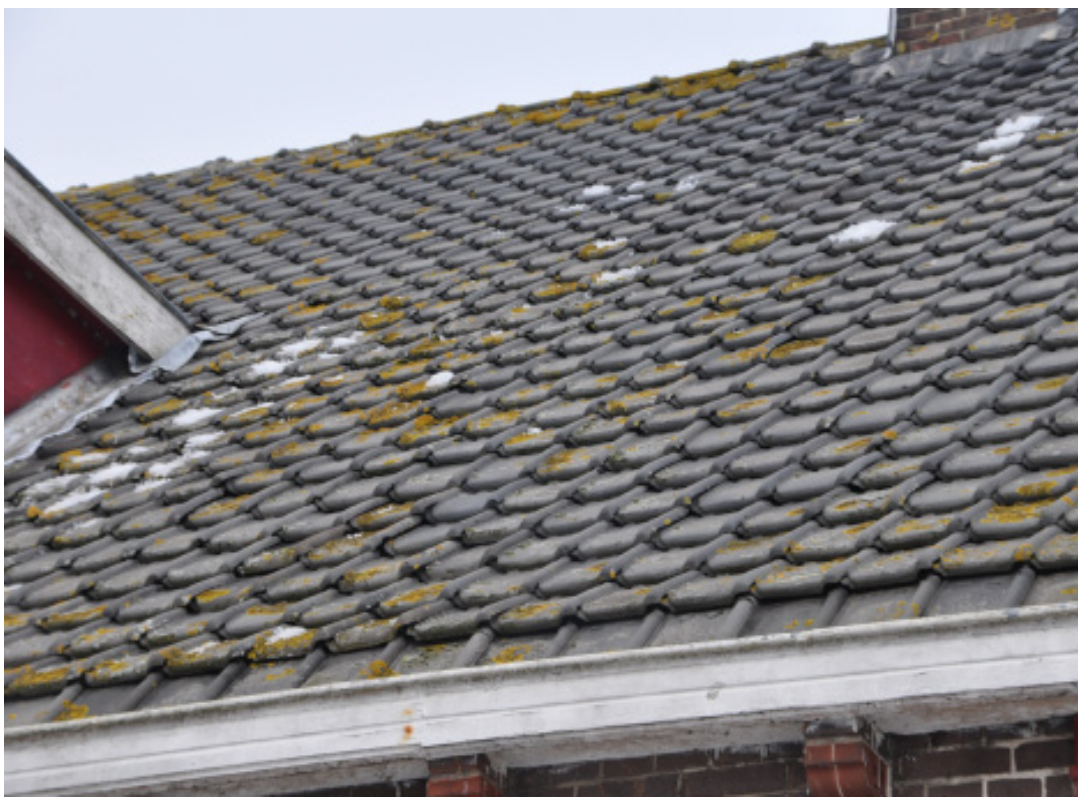
Dak van de te slopen woning.
