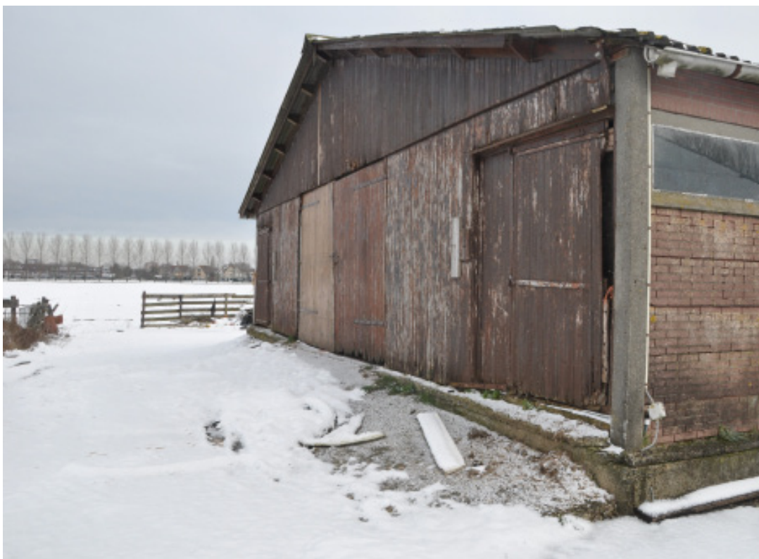
Een van de te slopen schuren.
