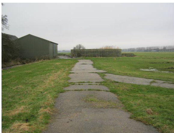
Foto 2: Aanzicht vanaf straatzijde op mestsilos: geplande nieuwbouwlocatie
