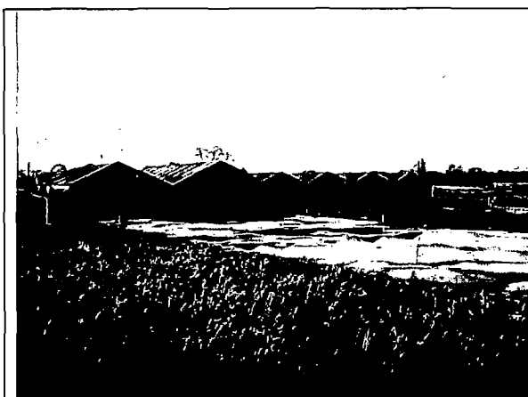
Foto 1: schuur, betonnen vloer en rietruigte
