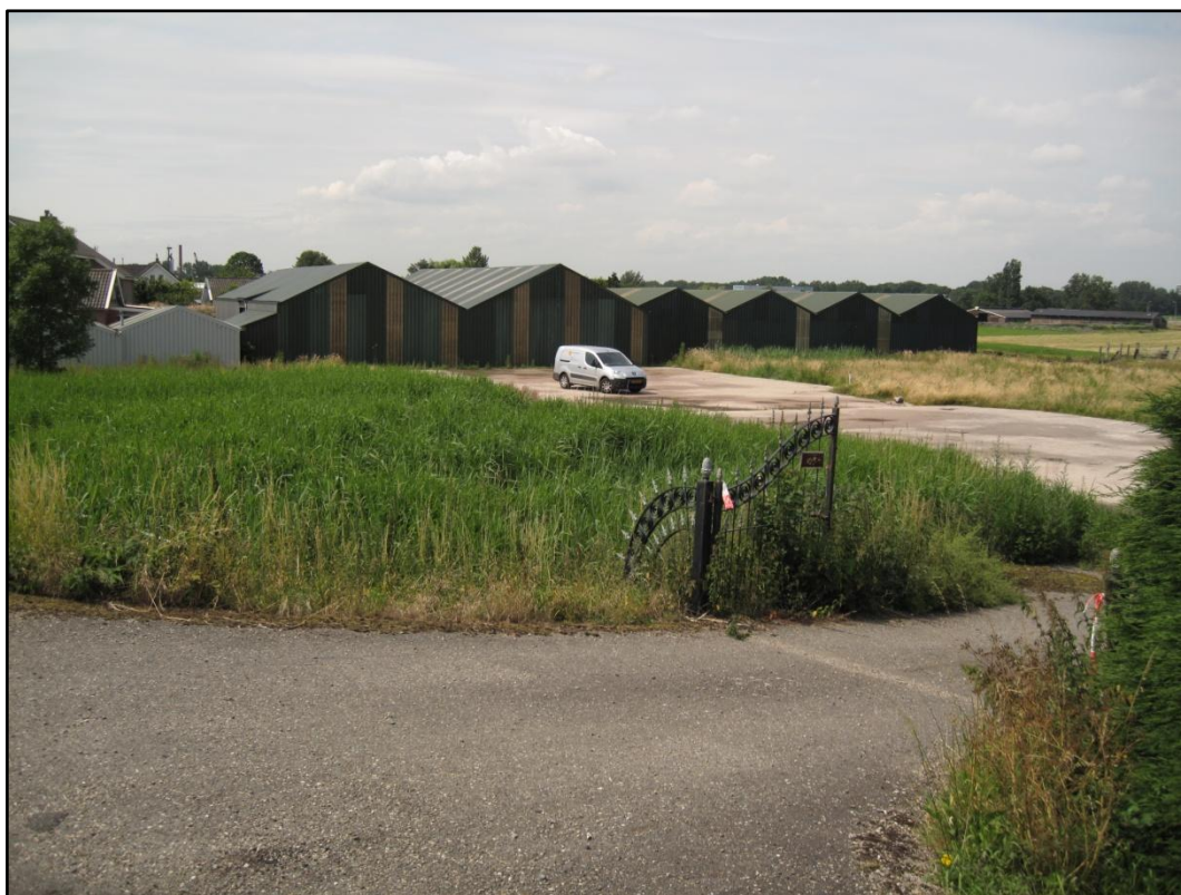
Afb. 4 Plangebied gezien in zuidwestelijke richting vanaf de Amsteldijk Zuid
