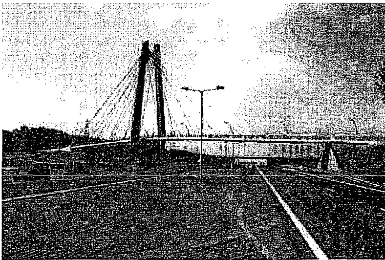
Foto 6.1 Fietstuibrug over de N22 en de Zuidtangent
