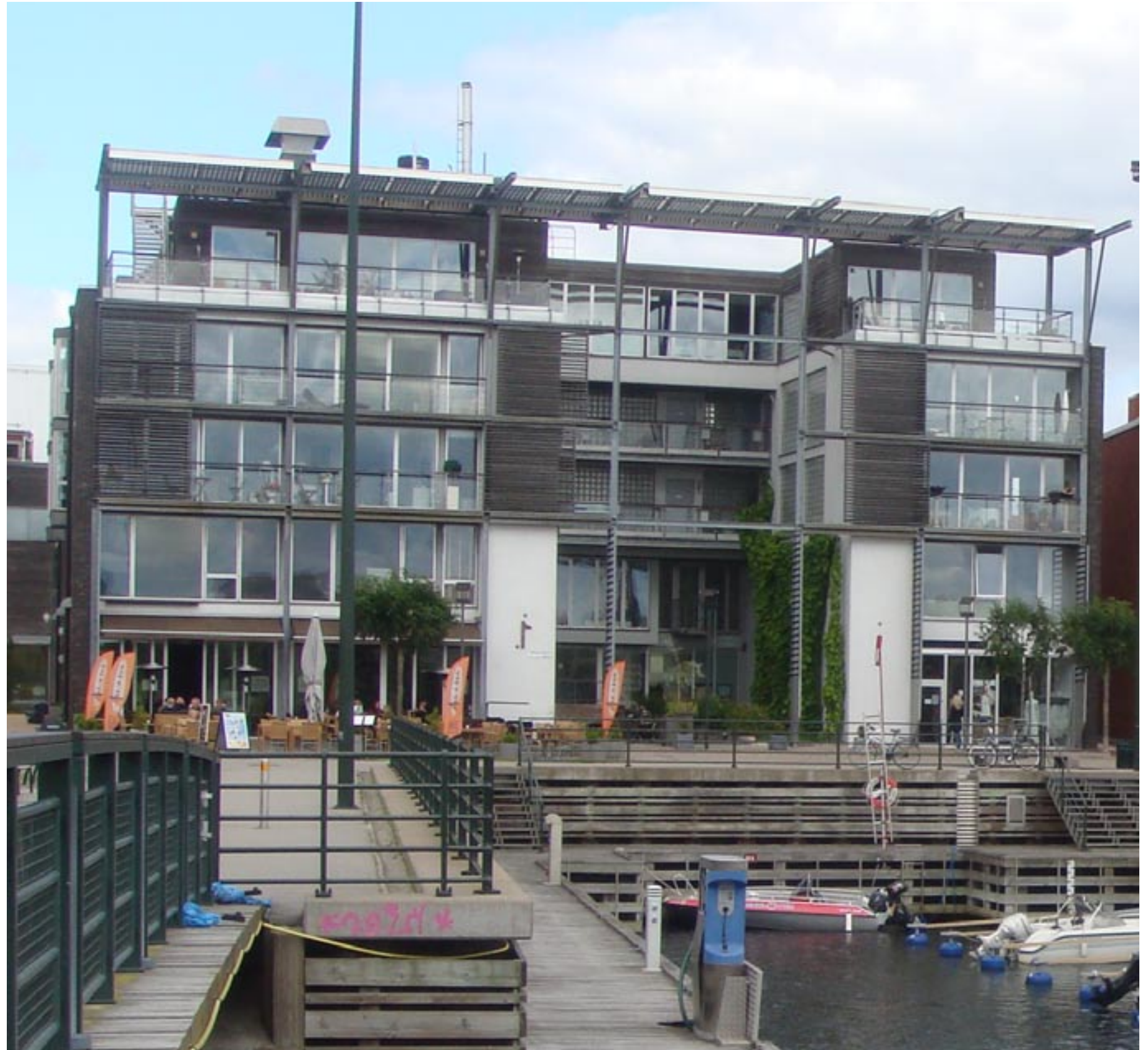
Referentie appartementengebouw met aanlegplaatsen.
