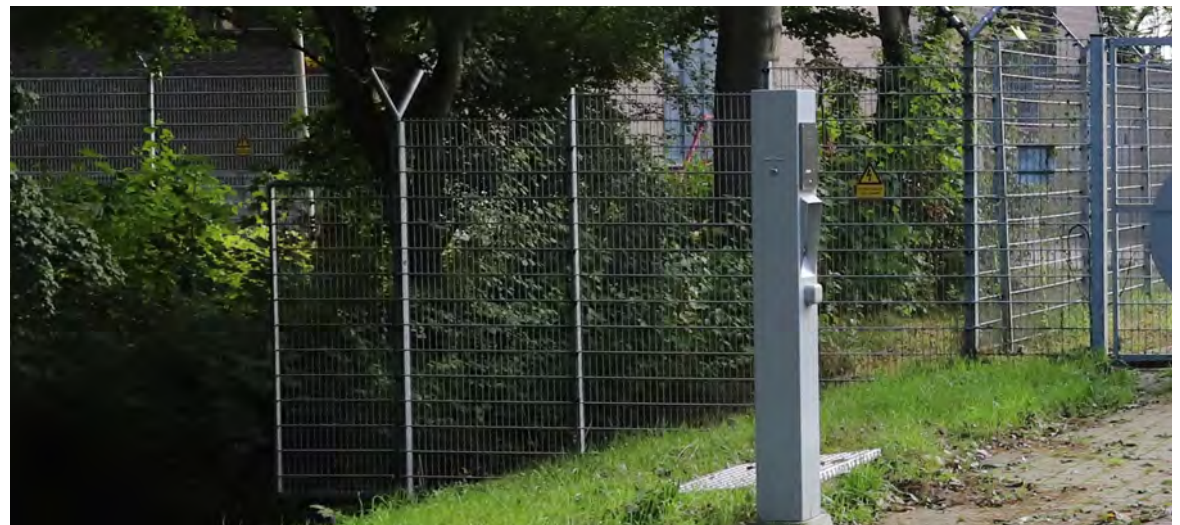
Hekwerk rondom huidig station
