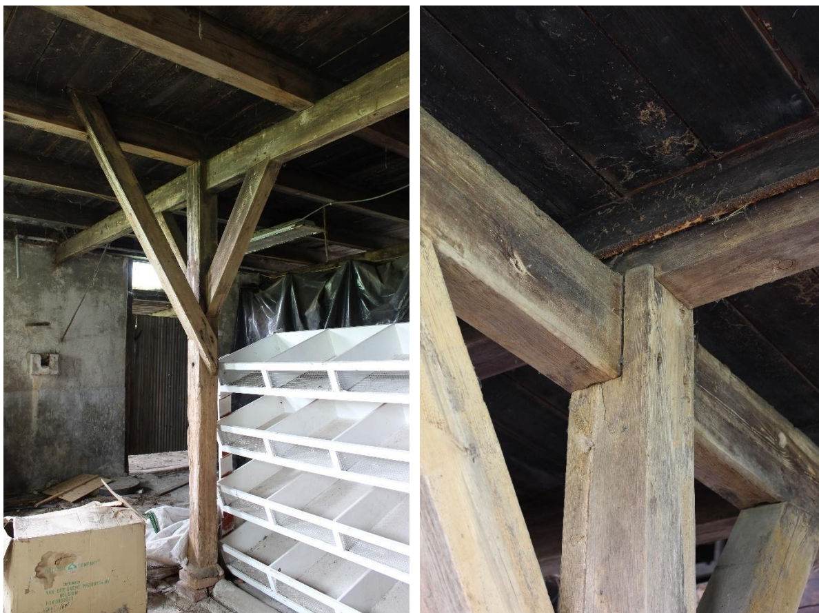
Figuur 12: Opnamen van de hoofddraagconstructie.
