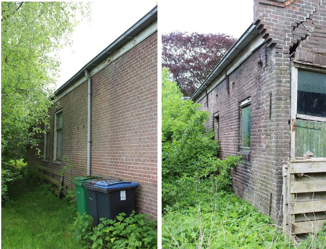
Figuur 8: De linker- en rechterzijgevel.
