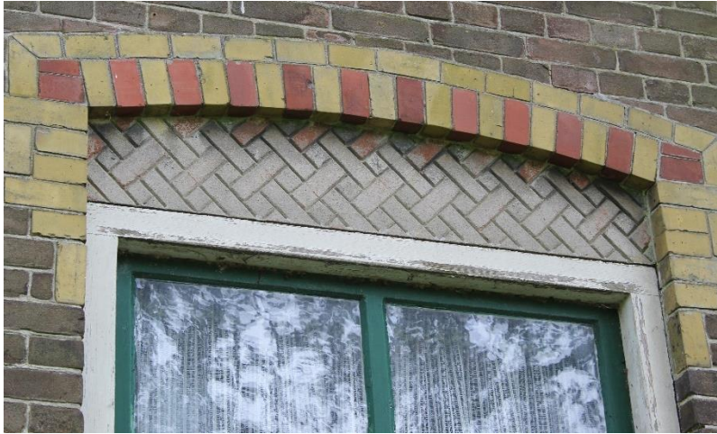
Figuur 4: De betonnen vulling van de boogtrommel boven één van de woonkamervensters. Er werd gebruik gemaakt van een mal met een baksteenpatroon. De kleurstelling was overeenkomstig met die van de segmentboog.
