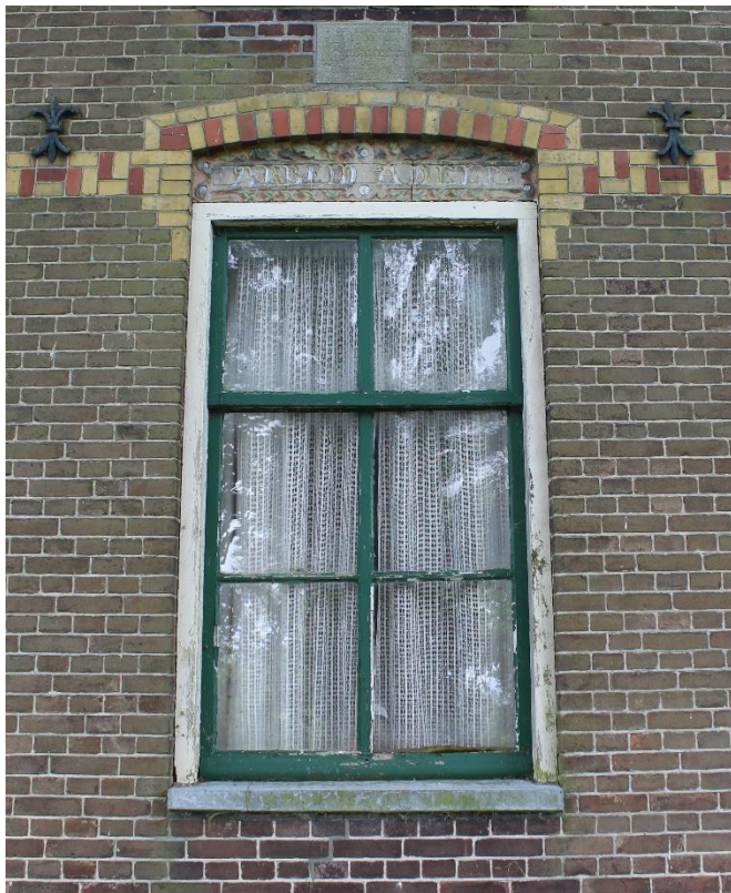
Figuur 6: Het centrale woonkamervenster. Duidelijk zichtbaar is dat de gevel met een bonte, maar subtiële kleurstelling werd uitgevoerd.
