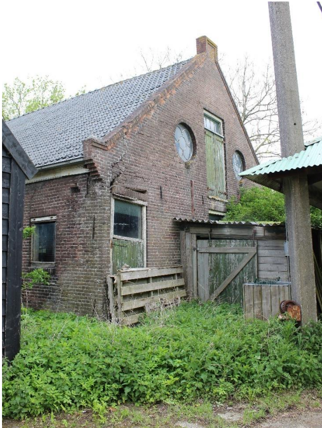
Figuur 9: De achtergevel.
