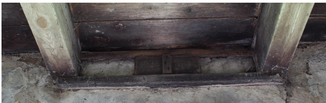
Figuur 11: Tussen de balken van de zoldervloer is een eenvoudig schuifmechaniek aangebracht.
