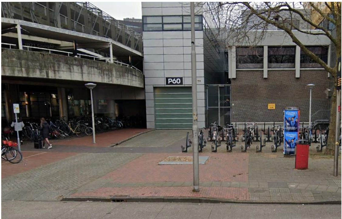
figuur 4 ingang laad- en losplaats vrachtwagens van P60 (bron: Google Streetview)
