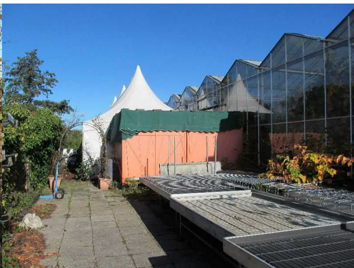
Achterzijde kas tuincentrum met tent en toiletunit
