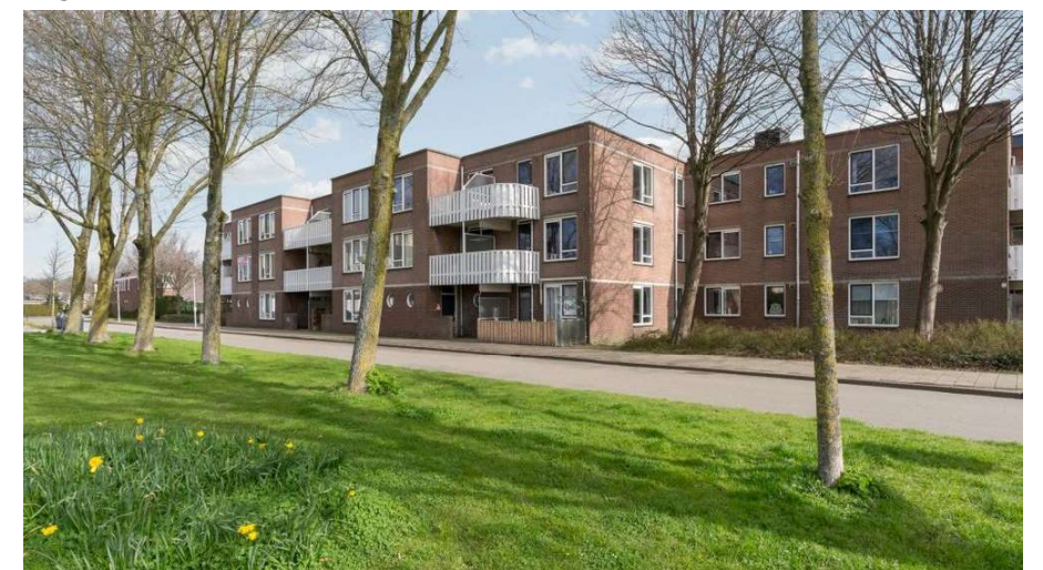
Woningbouw aan de noordzijde van het spoor
