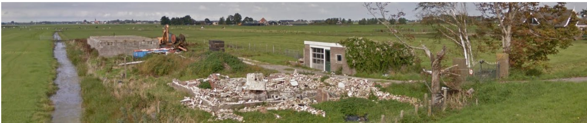
Plangebied gezien vanaf de Oostmijzerdijk, ten tijde van sloop, afbeelding: Google Streetview
