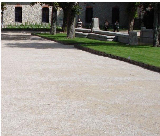
Referentie, oprit van halfverharding
