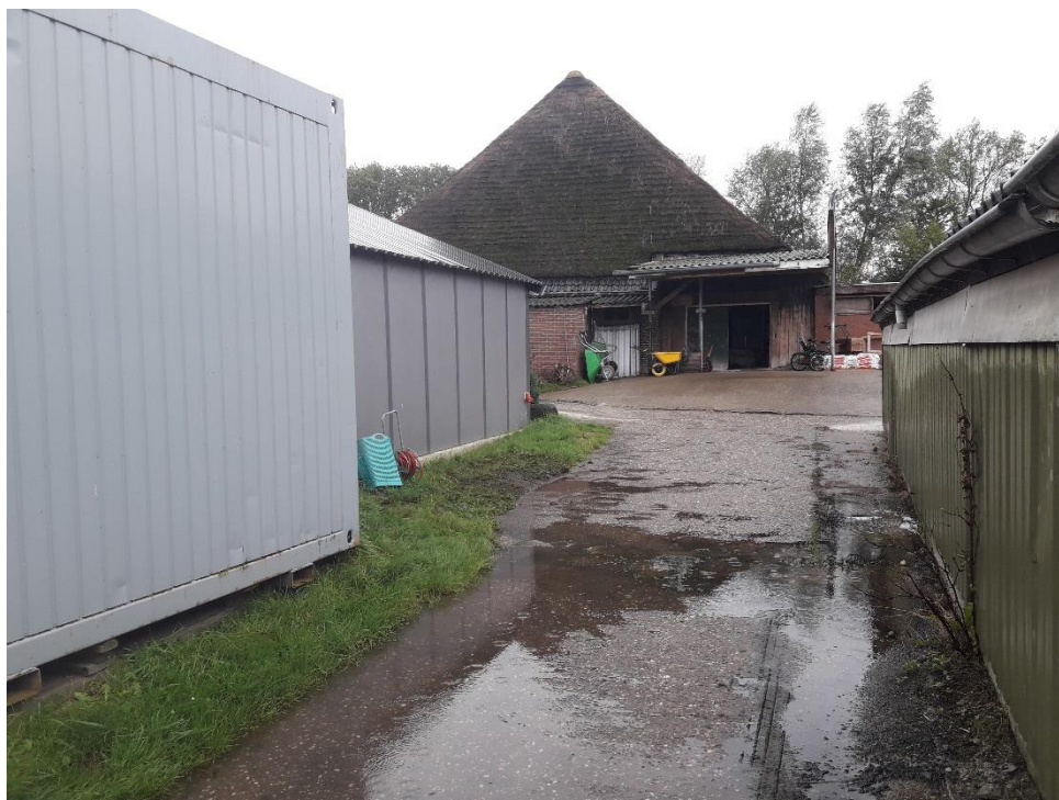
Foto 5: Zicht vanuit oostzijde op het centrale deel van de onderzoekslocatie.
