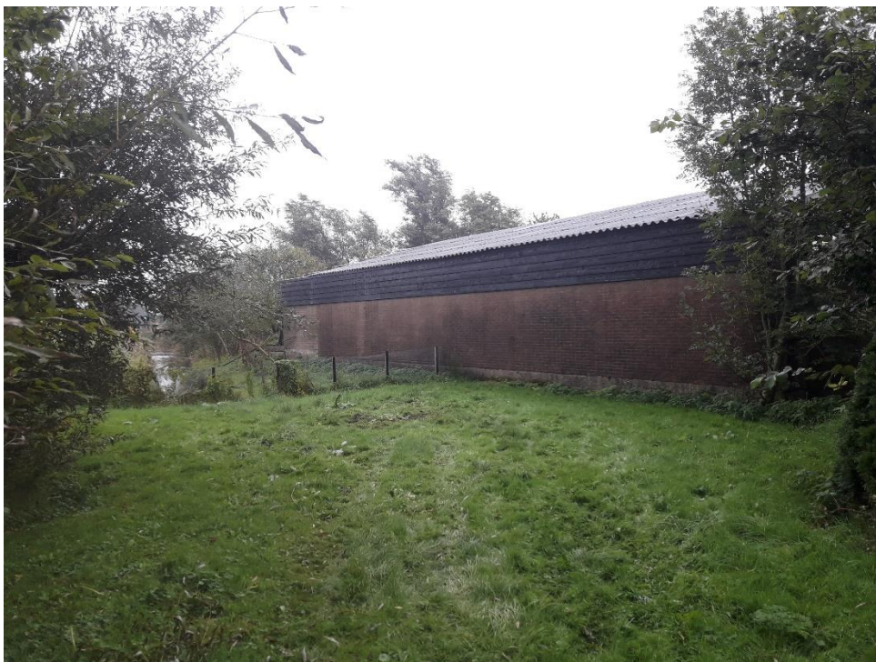
Foto 4: Zicht vanuit zuidwestzijde op het westelijke deel van de onderzoekslocatie.
