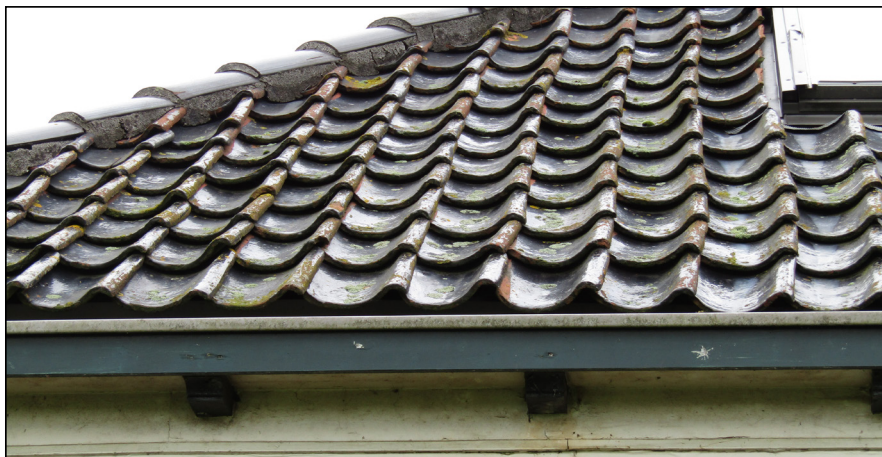
Figuur: de onderste rijen dakpannen bieden geschikt broedbiotoop voor de huismus én invliegopeningen voor vleermuizen. Vleermuizen kunnen verblijfplaatsen hebben tussen de verschillende daklagen.
