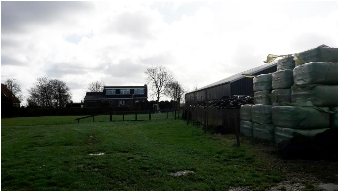
Figuur 8 Zicht vanaf de achterzijde (oostkant) van het erf naar de Zuidervaart
