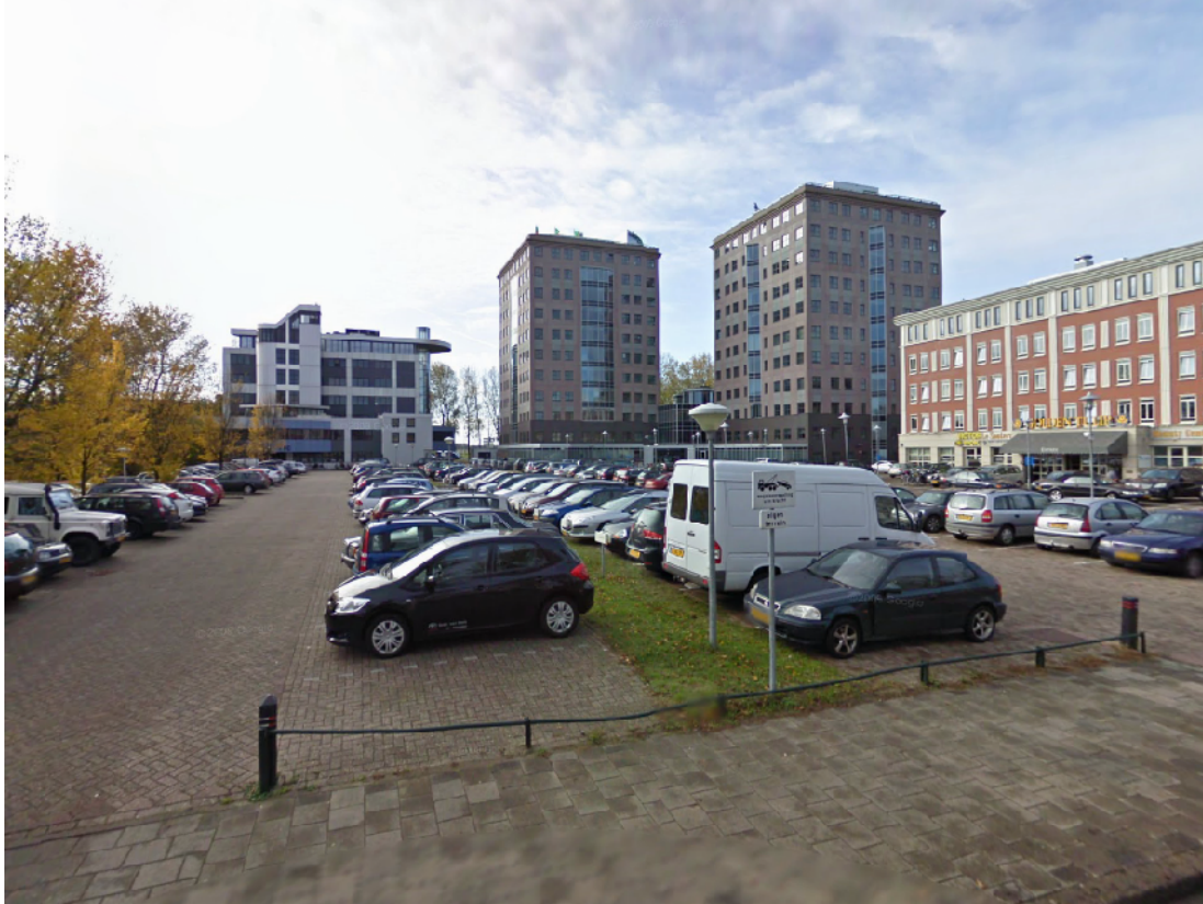
figuur 9: belendende gebouwen, gezien vanaf de projectlocatie
